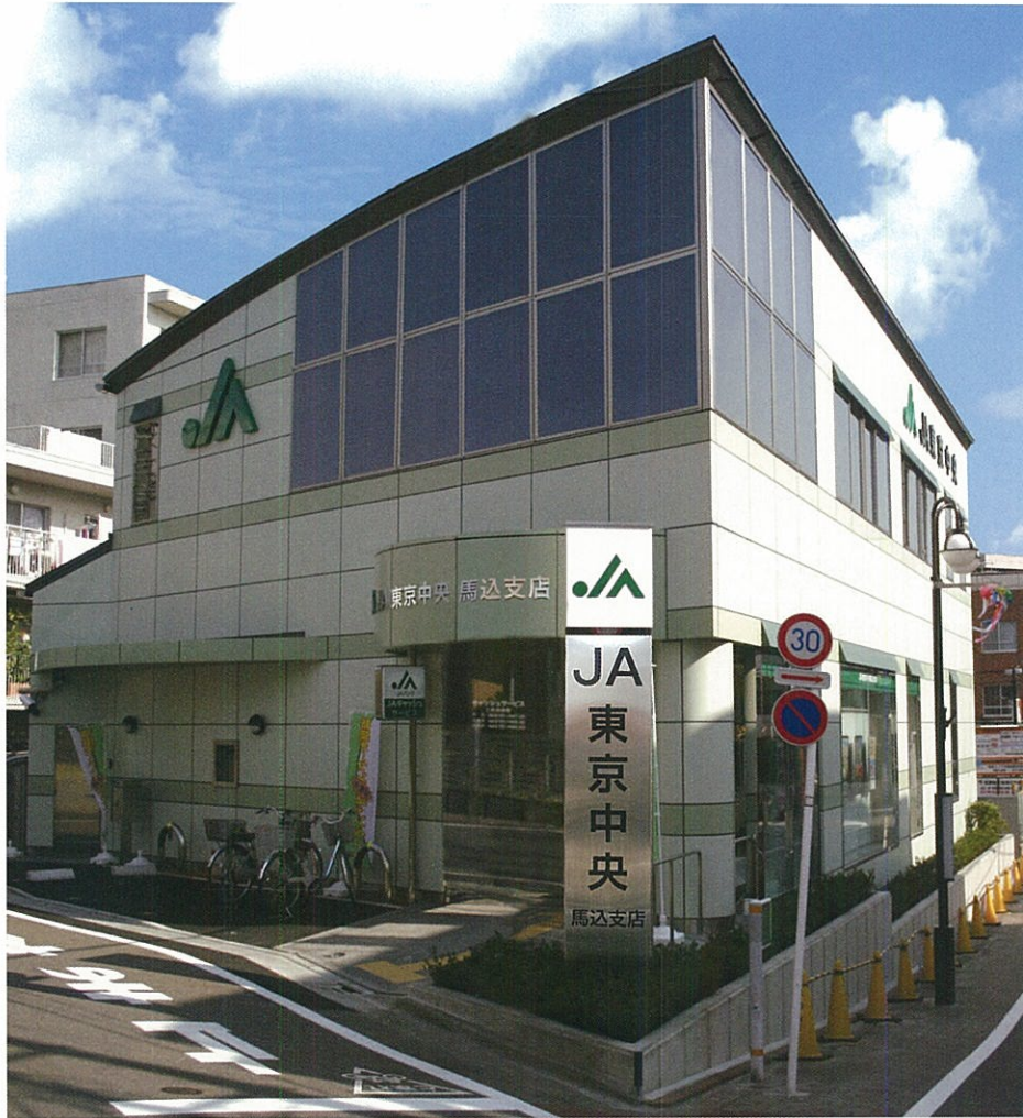
平成21年10月 馬込支店新築オープン
